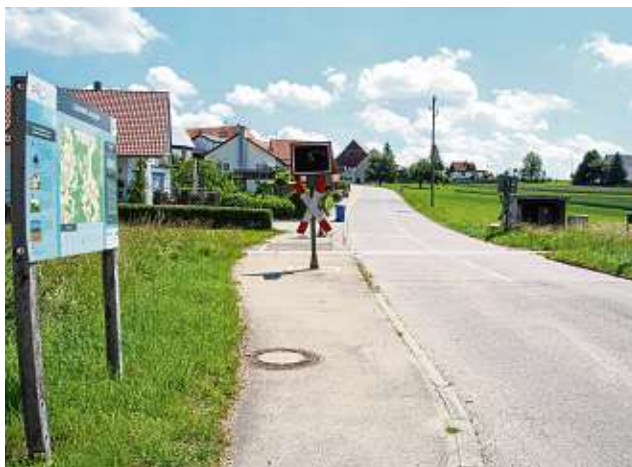
Der Bahnübergang der Ablachtalbahn im Sauldorfer Ortsteil Bichtlingen. BILD: MANFRED DIETERLE-JÖCHLE
